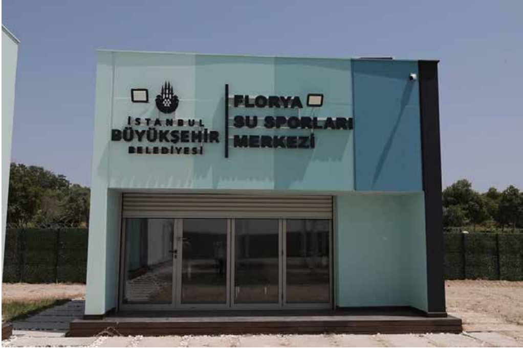
Şekil 3.35 İBB Florya Su Sporları Tesisi
