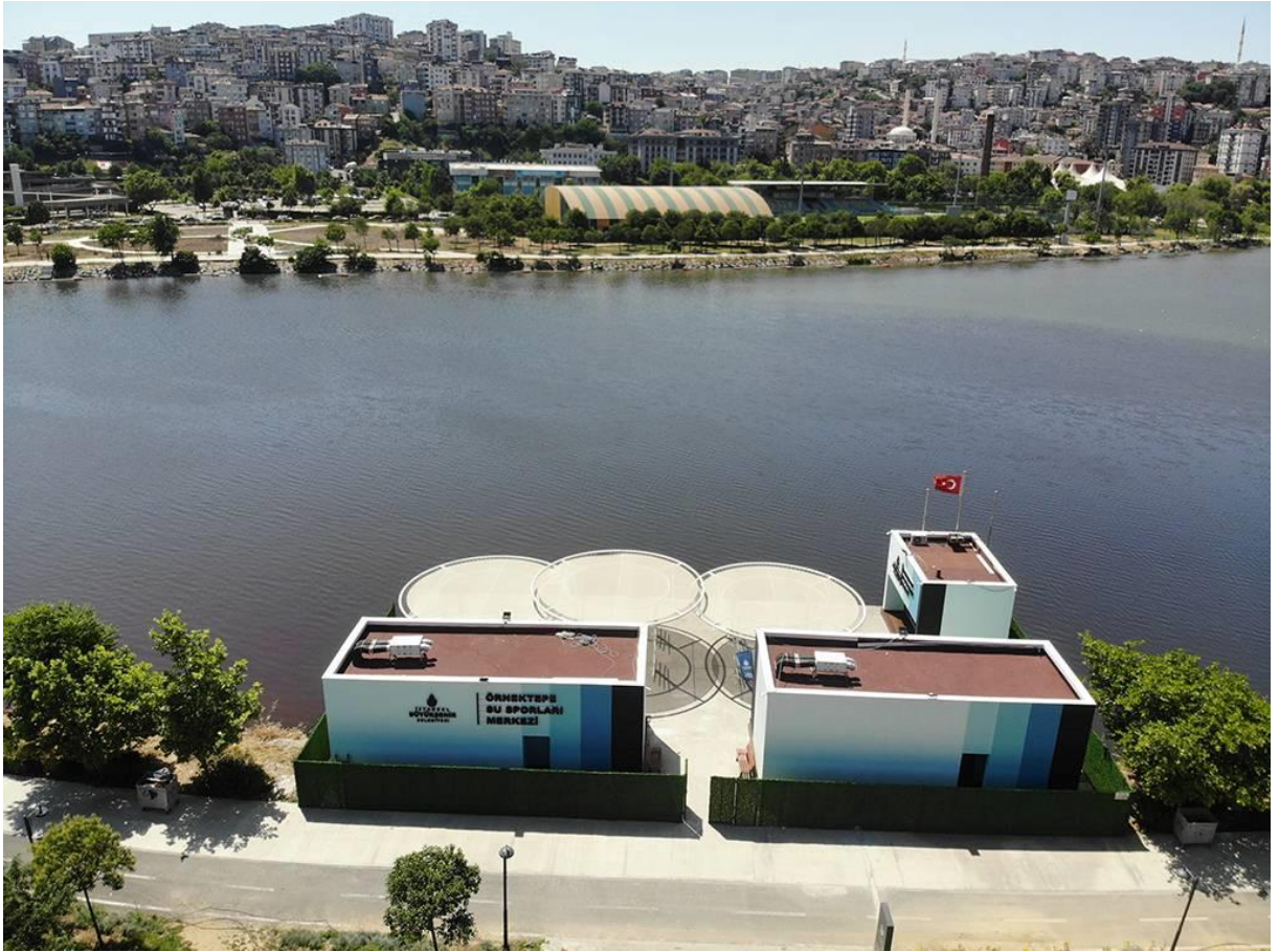
Şekil 3.36 İBB Örnektepe Su Sporları Tesisi
