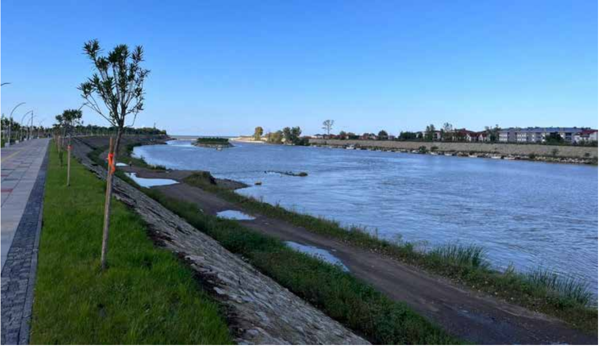
Şekil 5.12 Melet Irmağı Kıyı Yapısı
