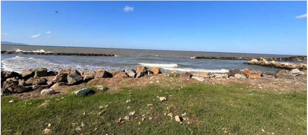
Şekil 5.10 Durugöl Mahallesi Gençlik ve Spor İl Müdürlüğü Tesisleri Kıyı Yapısı
