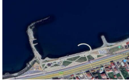
Görsel 49: Rize Yat Limanı İnşaat Alanı
